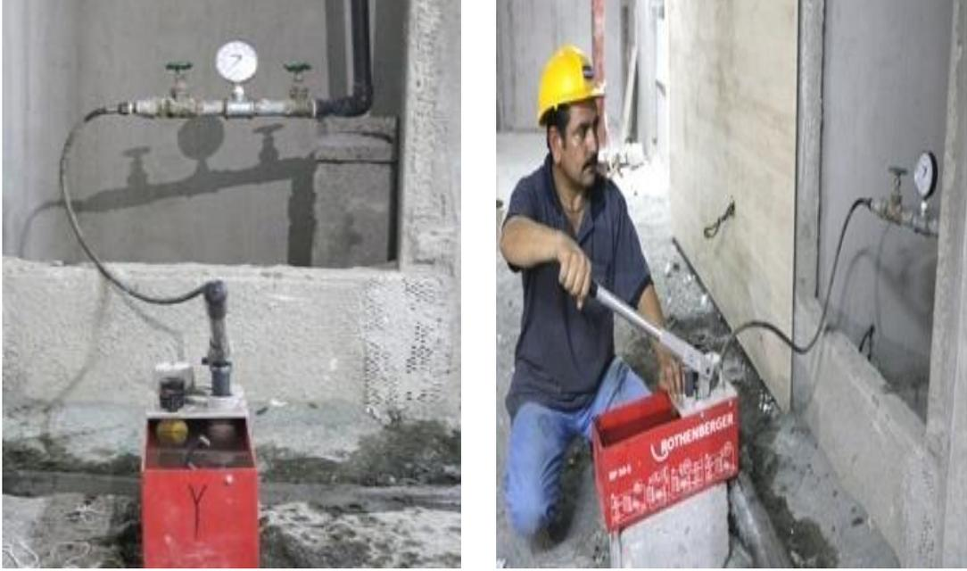
ماكينة اختبار ضغط المياه
